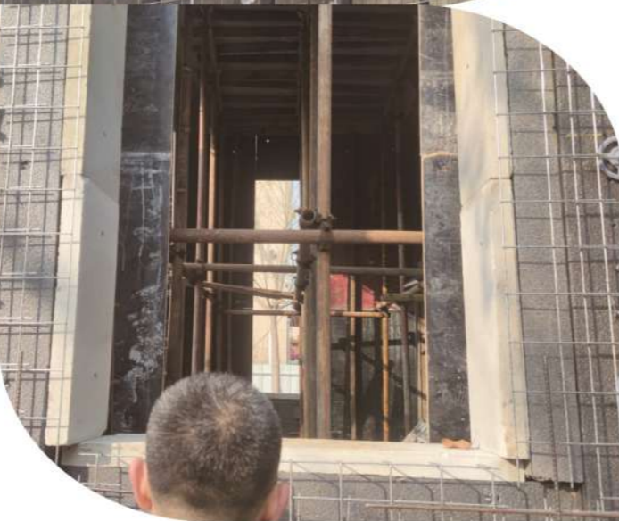
4 洞口断热桥处理
