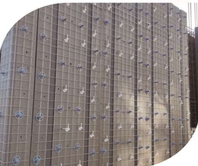
2 安装内置保温板和专用连接件
