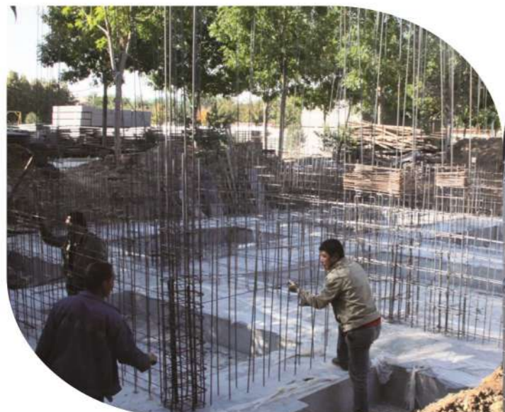
1 基础部分施工（防水、保温、钢筋）
