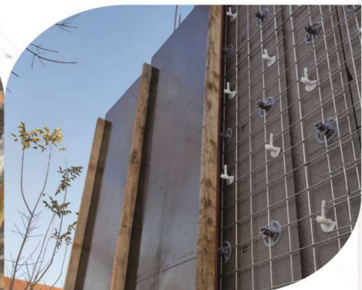
6 支设内外模板
