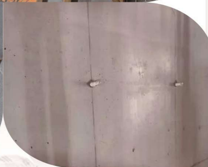
8 模板拆除墙面平整
